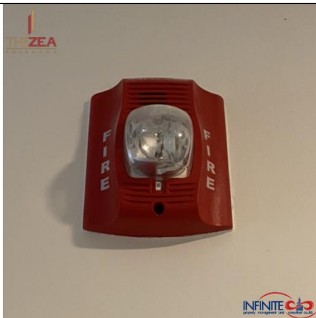
ลำโพงเตือนสัญญาณไฟไหม้ Fire Alarm Speaker
