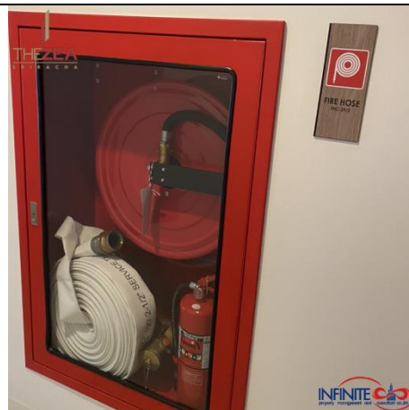
ตู้เก็บสายฉีดน้ำดับเพลิง Fire Hose Cabinet
